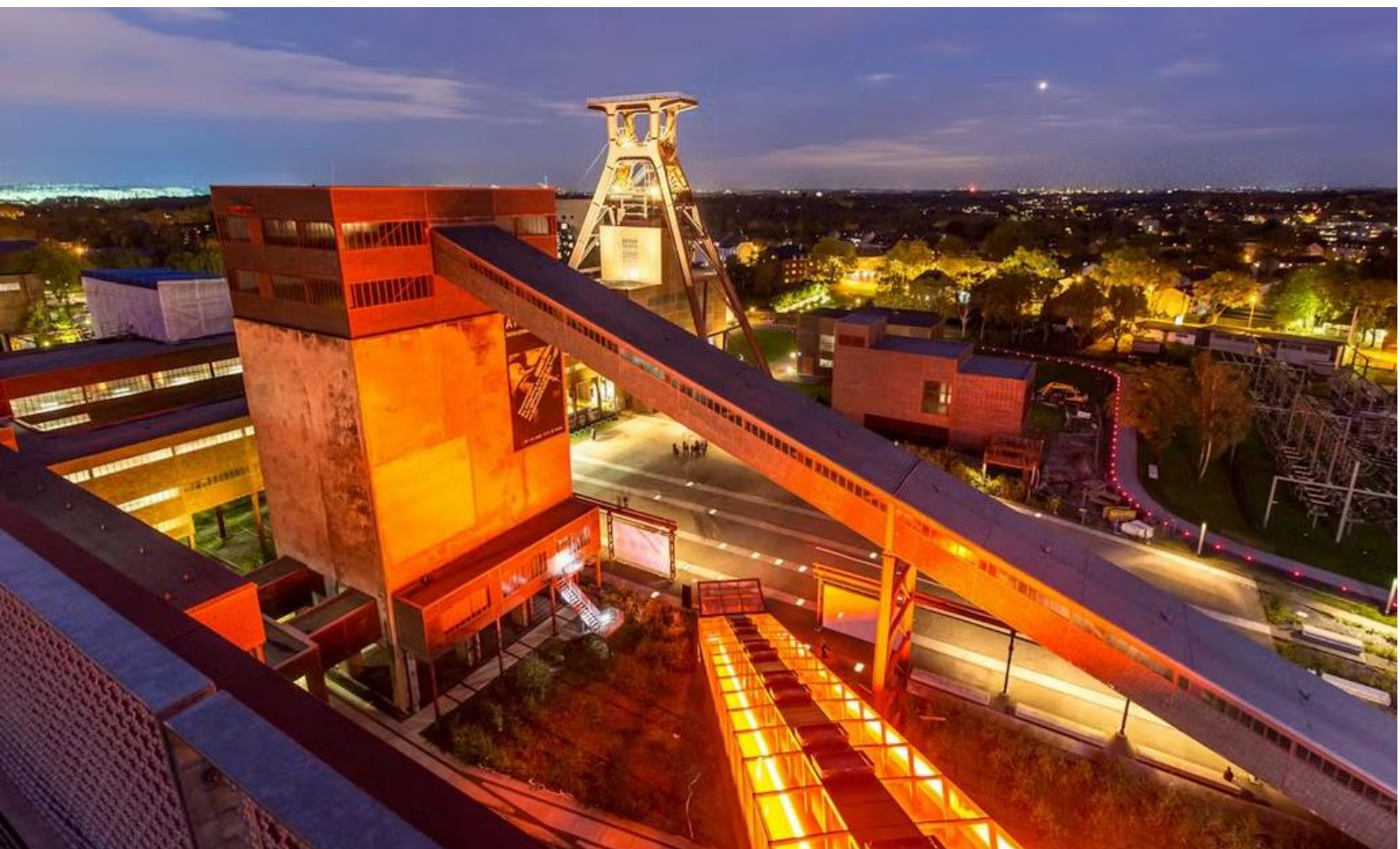
Uitzicht op het complex vanaf het uitkijkplatform op het Ruhrmuseum (dak van de kolenwasserij)
